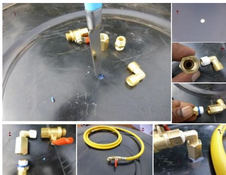
شکل ۶- نصب لوله تغذیه زباله
