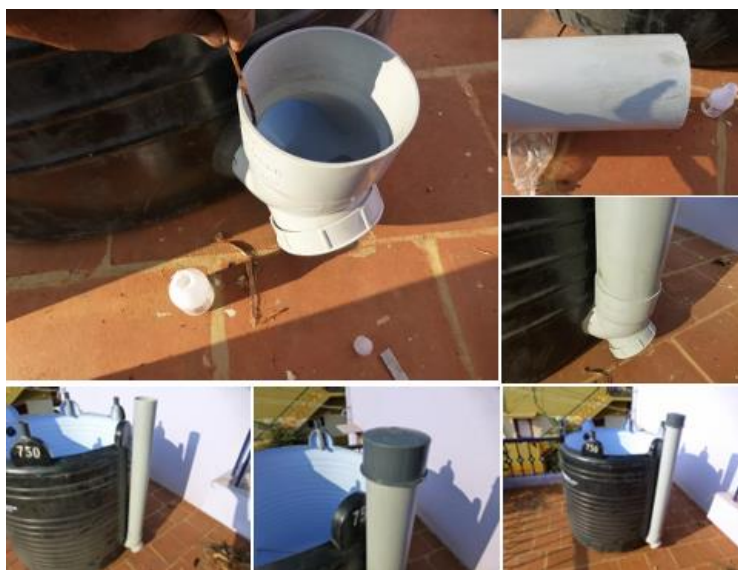
شکل ۵- مراحل نصب خروجی گاز از مخزن نگهدارنده گاز
