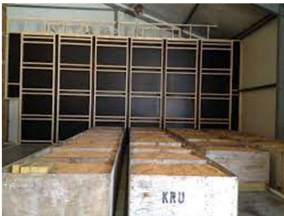
شکل ۲- نحوه استقرار دیواره شکافدار و پالت‌های سیب‌زمینی در یک انبار سرد
