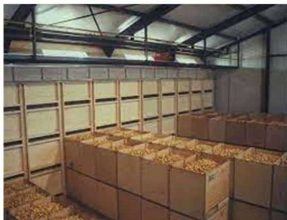
شکل ۲- نحوه استقرار دیواره شکافدار و پالت‌های سیب‌زمینی در یک انبار سرد
