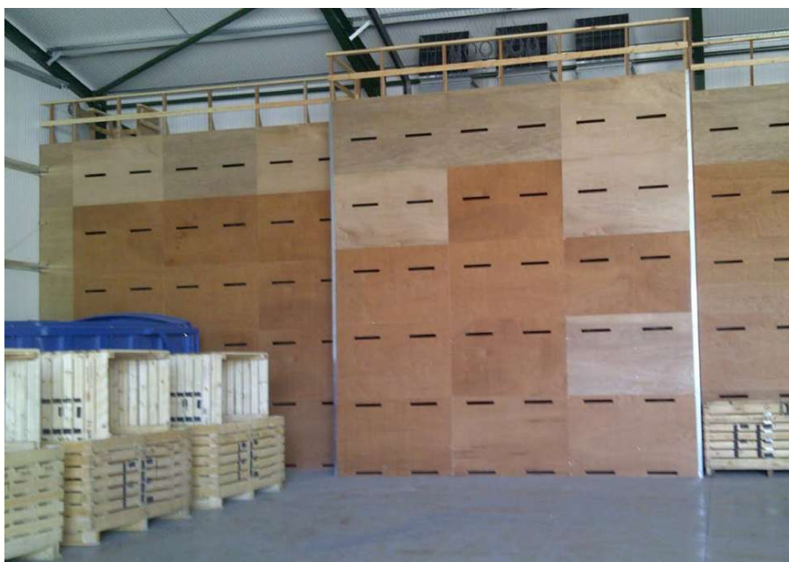
شکل ۵- دیواره مکش ترکیب شده با دیواره شکافدار که در زیر سامانه دمنده انبار تعبیه شده است
