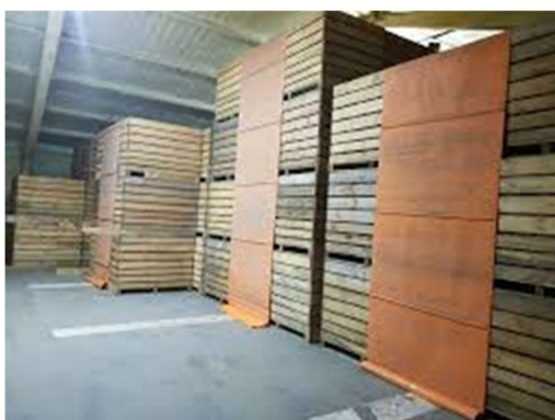
شکل ۴- نحوه استقرار و عملکرد پوشش برزنتی مسدودکننده فضای بین ردیف‌های جعبه/گونی/پالت‌های سیب زمینی در سامانه دیواره مکش انبار سیب زمینی
