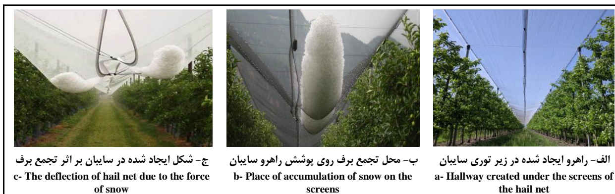
شکل ۳- وضعیت عمومی و تغییر شکل توری سایبان‌ها بر اثر تجمع برف روی آن‌ها Fig. 3- The general condition and deflection of the screens hail net due to the accumulation of snow
