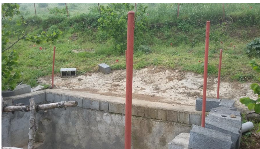
شکل ۵- جمع‌آوری آب باران از سطح کوچک آب‌گیر و ذخیره آن در مخزن
