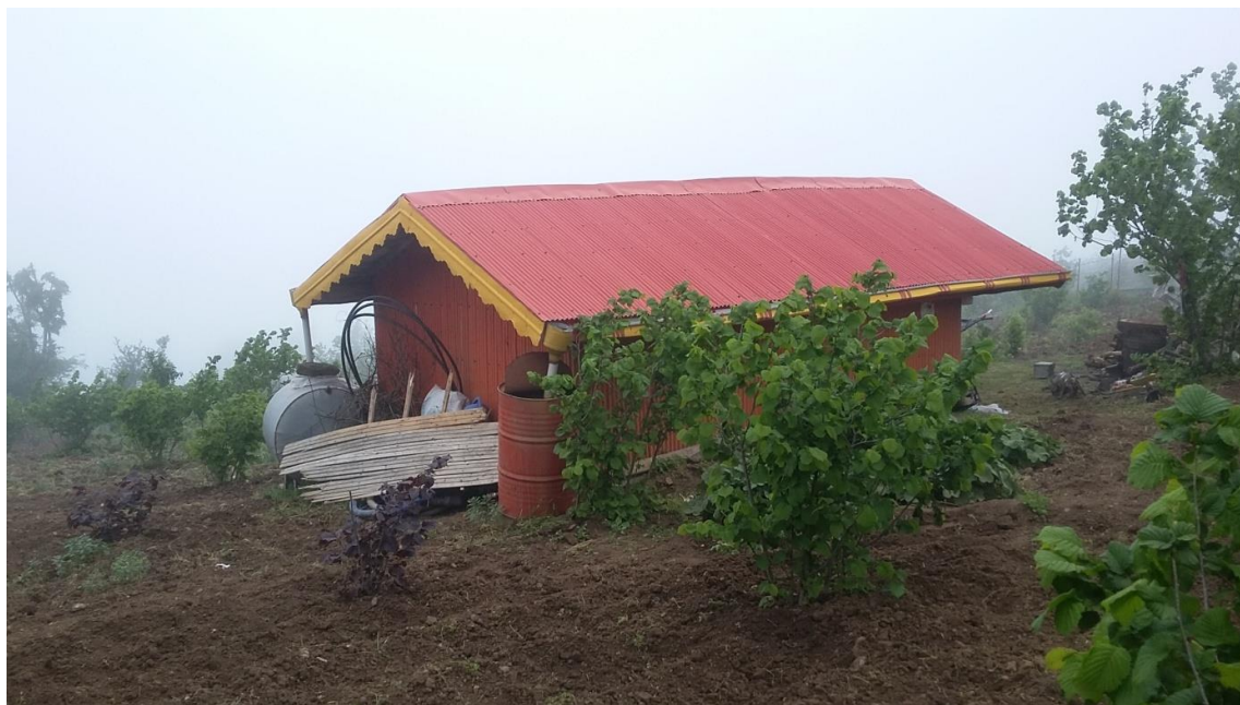
شکل ۴- نمایی از استحصال آب باران از سقف شیروانی ساختمان در روستای کوهستانی سراورسو اشکورات رودسر
