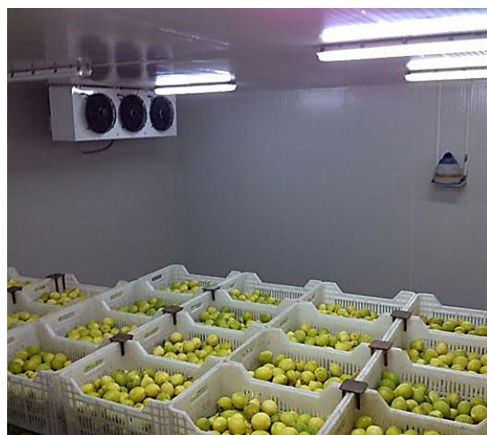
شکل ۹- خنک‌کردن سبدهای انجیر با هوای سرد تحت فشار
