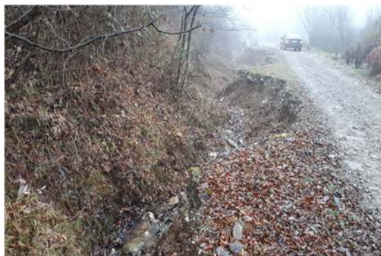
شکل ۲- تأثیر رواناب سطحی بر جاده جنگلی
