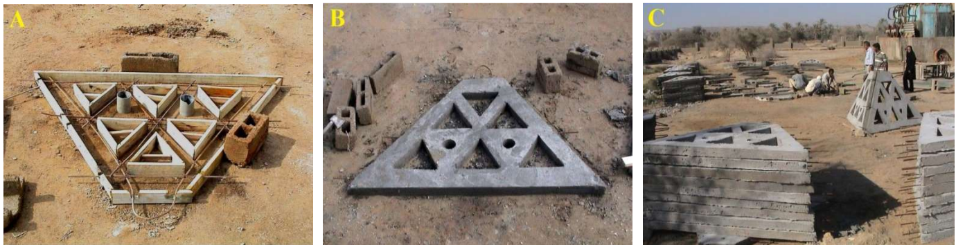
شکل ۱. ساخت وجه‌های صخره‌های مصنوعی هرمی شکل: A. نصب قالب‌های چوبی ساده روی زمین و قرار دادن میلگردها و ریخته شدن بتون در قالب‌ها، B. وجه آماده در حال خشک شدن، C. تعدادی از وجه‌های آماده جهت ساخت صخره‌های مصنوعی هرمی شکل
