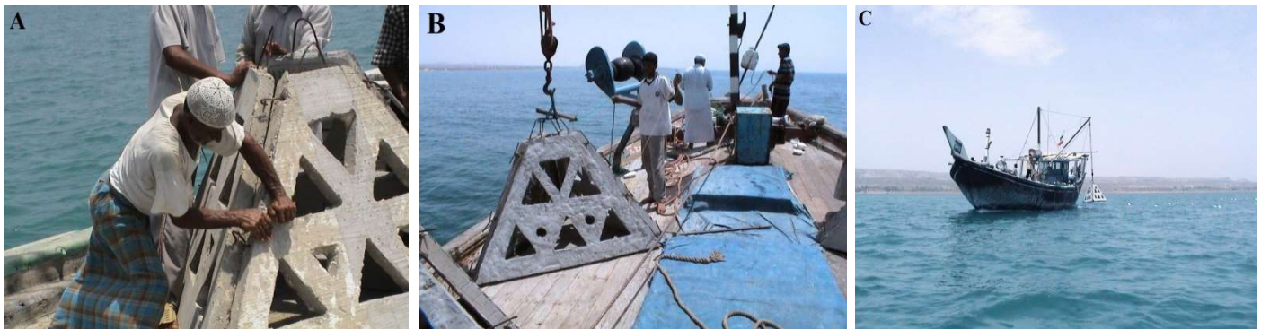
شکل ۳. A. مونتاژ سازه‌ها بر روی عرشه، B. اتصال سازه‌ها به وینچ‌های بالابر، C. انتقال بسترهای مصنوعی به درون دریا
