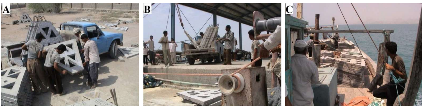
ساخت شکل ۲. انتقال وجه‌های ساخته‌شده طی ۳ مرحله A و B و C از محل به درون لنج
