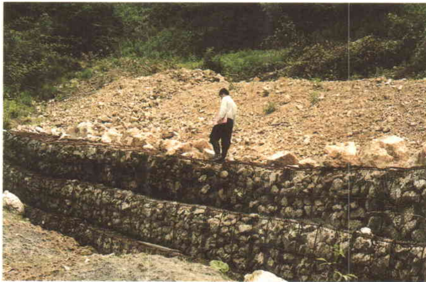
عکس شماره ۲- نشست و ریزش مداوم سطح جاده (مرمت آنرا نشان می‌دهد) (طرح جنگلداری زیارت - دانگ)
