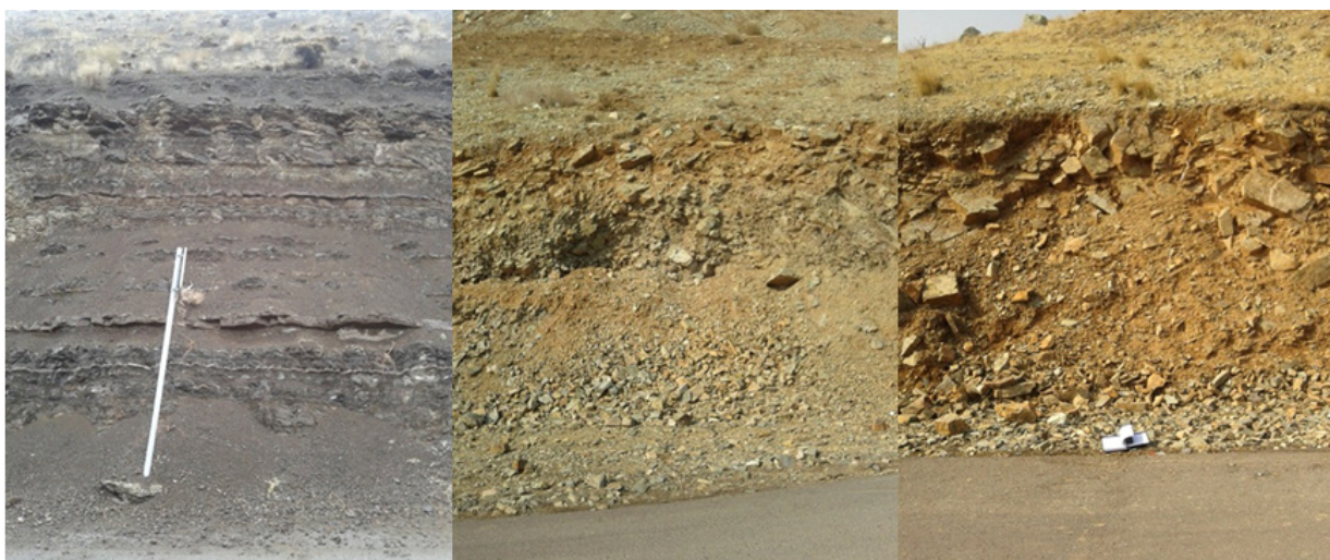
شکل ۴- رسوبات واریزه‌ای جدید در پای دیواره خاکبرداری؛ به فقدان پوشش گیاهی توجه شود.
